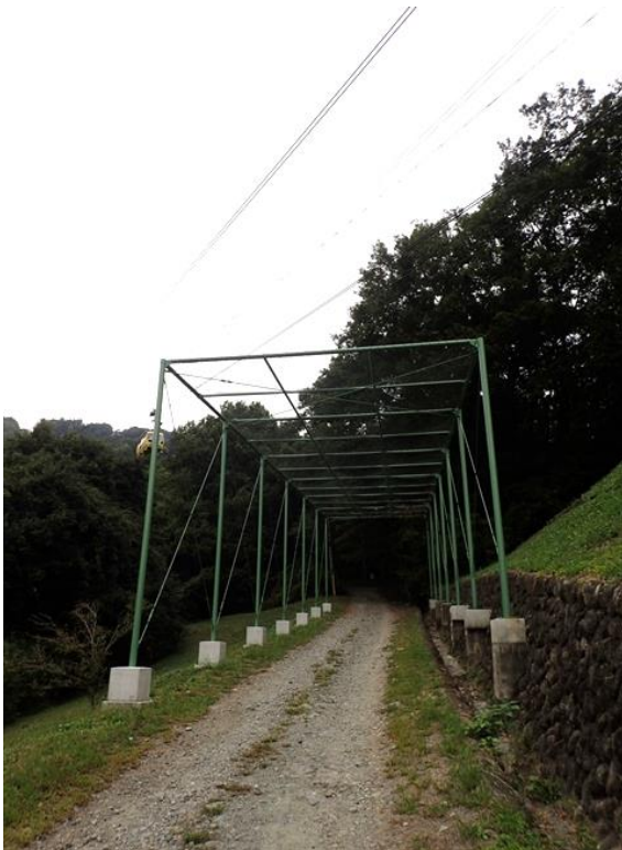
落下物防止柵の設置 (町道長瀬43号線)
